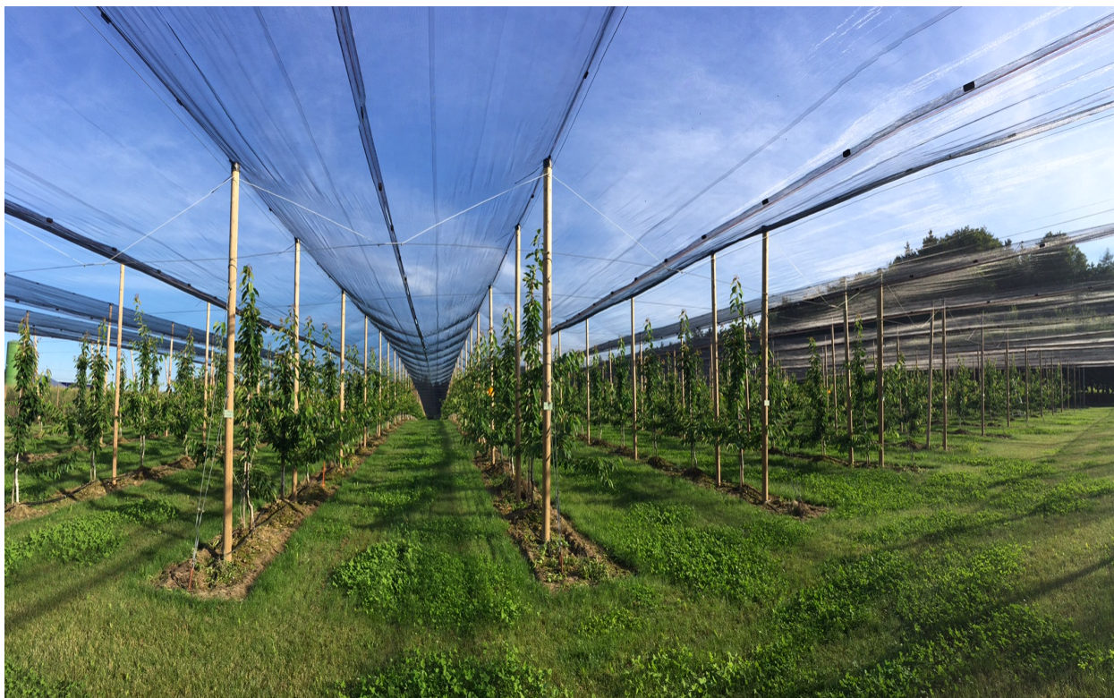
Hagelschutznetzkonstruktion Totaleinnetzung mit Vorhaupt
