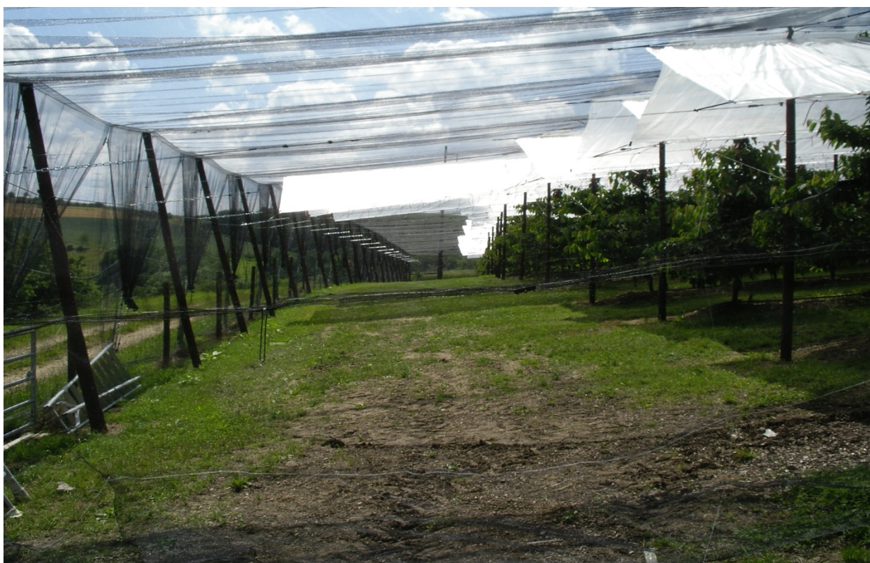
Kirschenanlage mit Hagelschutznetz Totaleinnetzung ("Käfigsystem") und Regendach
